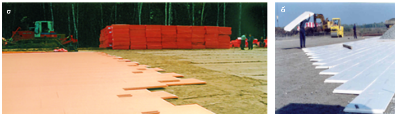
Рис. 2. Укладка изоляции из экструдированного пенополистирола (XPS-плит): а – дорожное полотно; б – аэродромное покрытие
