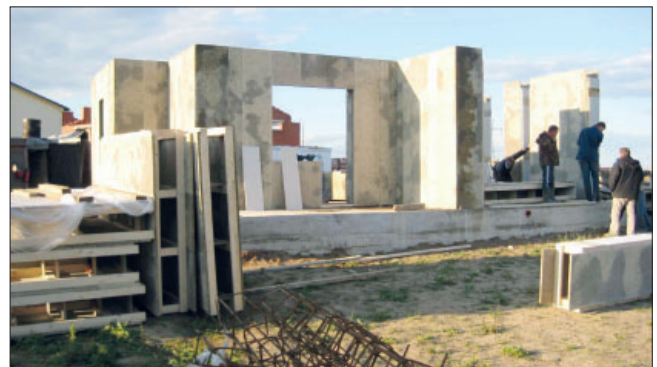
Рис. 3. Скоростное возведение ограждающих конструкций малоэтажного дома
