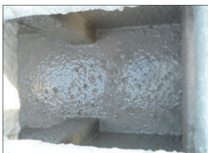
Рис. 5. Свежеуложенная пеногипсовая масса в пустоты каркасно-обшивных стен
