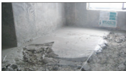
Рис. 4. Заливка перекрытия пеногипсовой массой
